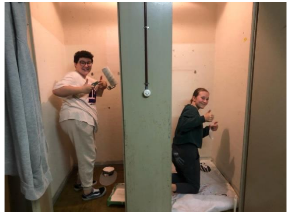
Umbau der neuen Jugendräume
